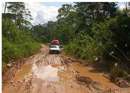
Carreteras deterioradas por las continuas lluvias.
