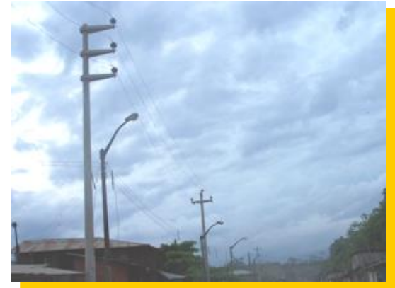
Instalación redes eléctricas
