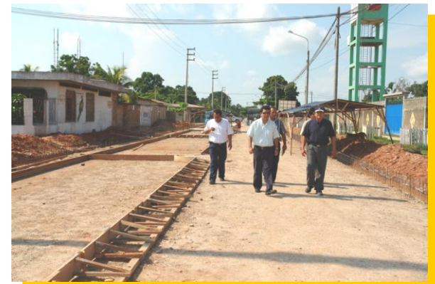
Pavimentación Jr. Amazonas
