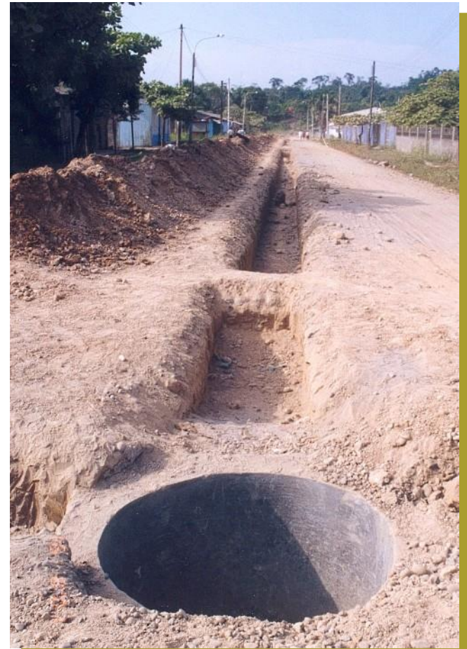
Instalación desagüe Pto Esperan - Purus
