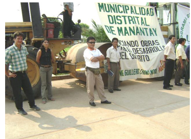
Maquinaria en Manantay para mejoramiento de calles
