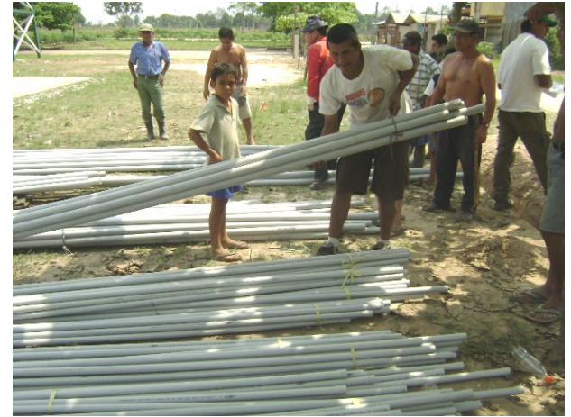
Entrega de tubos para redes de agua
