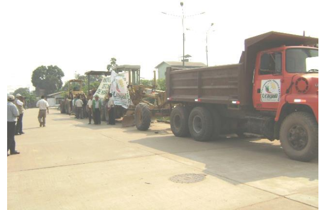
Maquinaria para mejoramiento de vías
