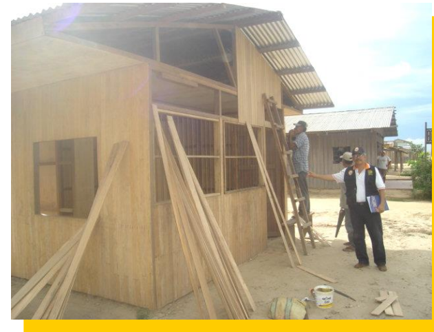
Construcción caseta seguridad ciudadana
