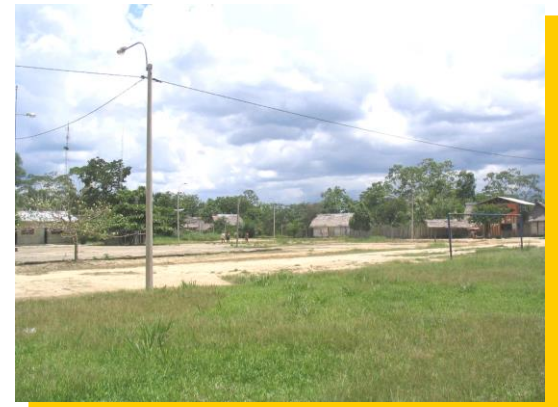
Iluminación caserío Santa Rosa
