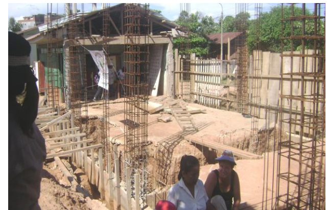
Construcción aulas I.E El Trebol
