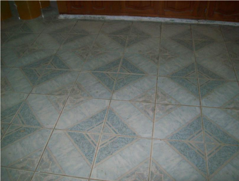
El piso no cuenta con sumideros, el piso es de mayolicas.
