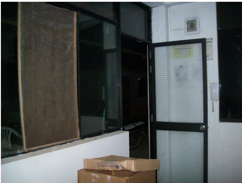
Colocar cortinas de flecos en la puerta de acceso a la zona de produccion Colocar micas de proteccion para caso de rotura de las ventanas. Colocar un sistema de extraccion de aire en la ventana sobre la zona de coccion.
