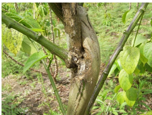
Fig.62: Daño ocasionado por "Tornero" en tutor muerto y tallo de Sacha inchi
