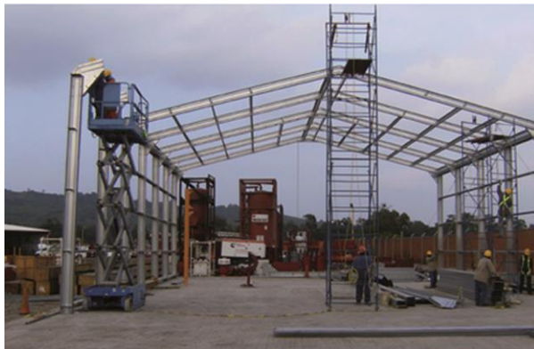
ARMADO DE ESTRUCTURA.
