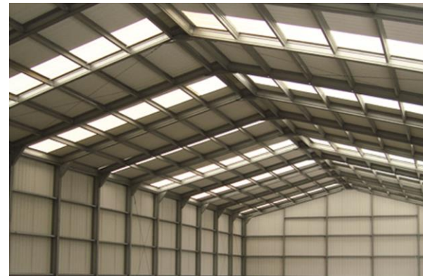
TECHO Y TERMINADOS.
