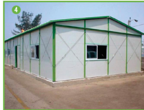
TECHO Y TERMINADOS.
