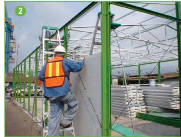
COLOCACIÓN DE LOS PANELES.
