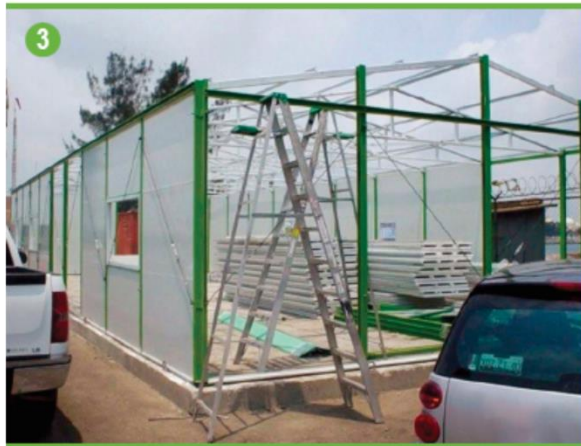
COLOCACIÓN DE PUERTAS Y VENTANAS.
