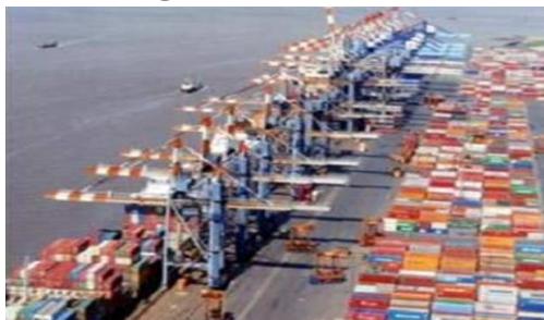
Descarga en destino
