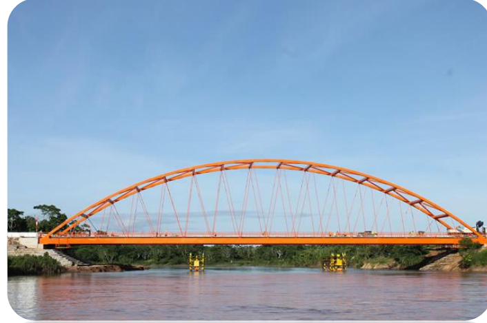
TRAMO 1, PUENTE YURIMAGUAS
