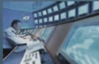
Sistema de vigilancia
