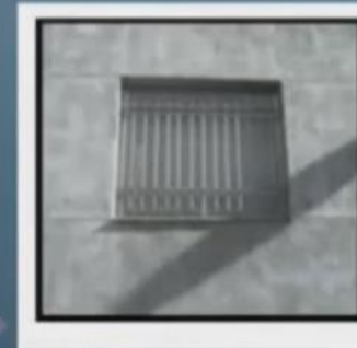
Buenas condiciones, sin fracturas
